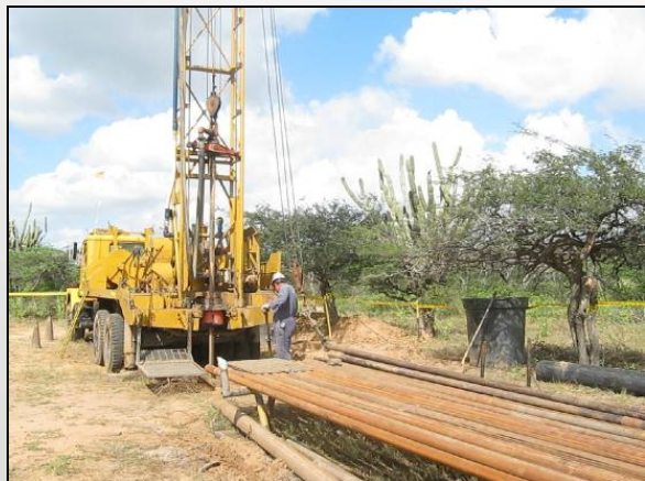
Perforación del pozo en Jatkusirra
