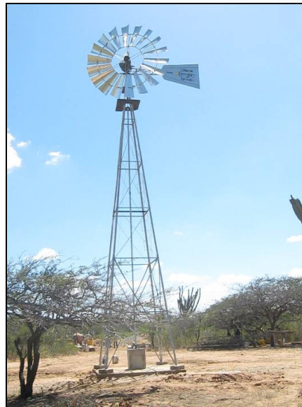
Molino instalado en Jatkusirra
