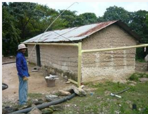
Captación de agua lluvia en techo de vivienda familiar. Resguardo de Zahíno.
