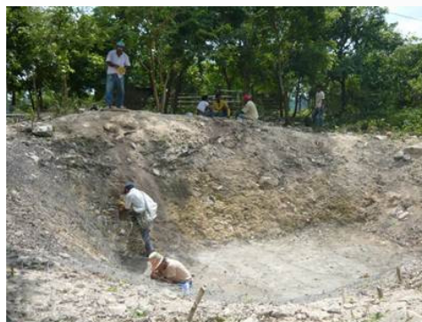
Instalación de mallas de ferrocemento para impermeabilización del reservorio instalado en el resguardo Rodeíto-El Pozo
