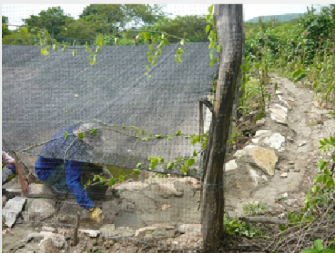
Construcción de estructura de protección de reservorio. Zahíno.
