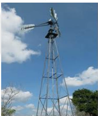
Molino instalado en la comunidad de Patsuarali
