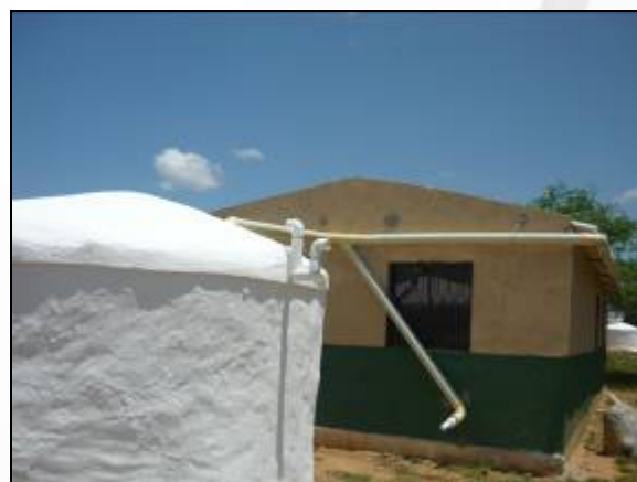
Sistema de captación y almacenamiento de agua lluvia. Comunidad Jirijitpana
