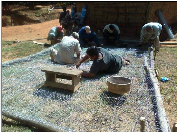
Construcción de matrices para Ferrocemento
