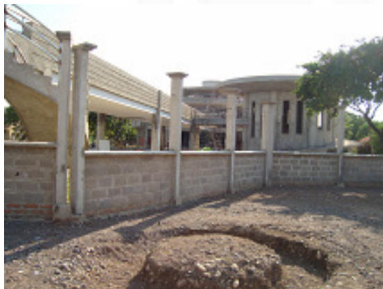
Fachada I.E. Pablo VI
